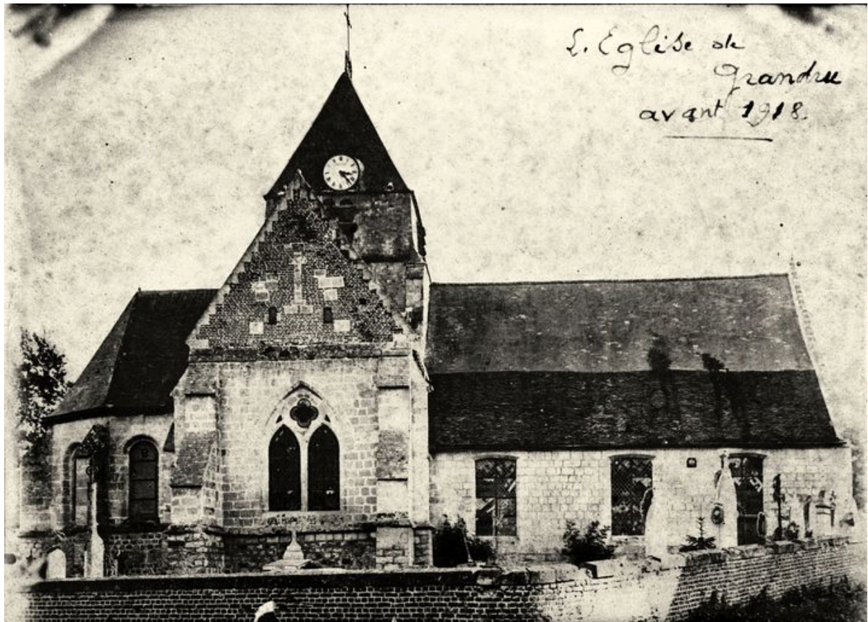
Élévation nord. Etat avant 1914 (AP).
