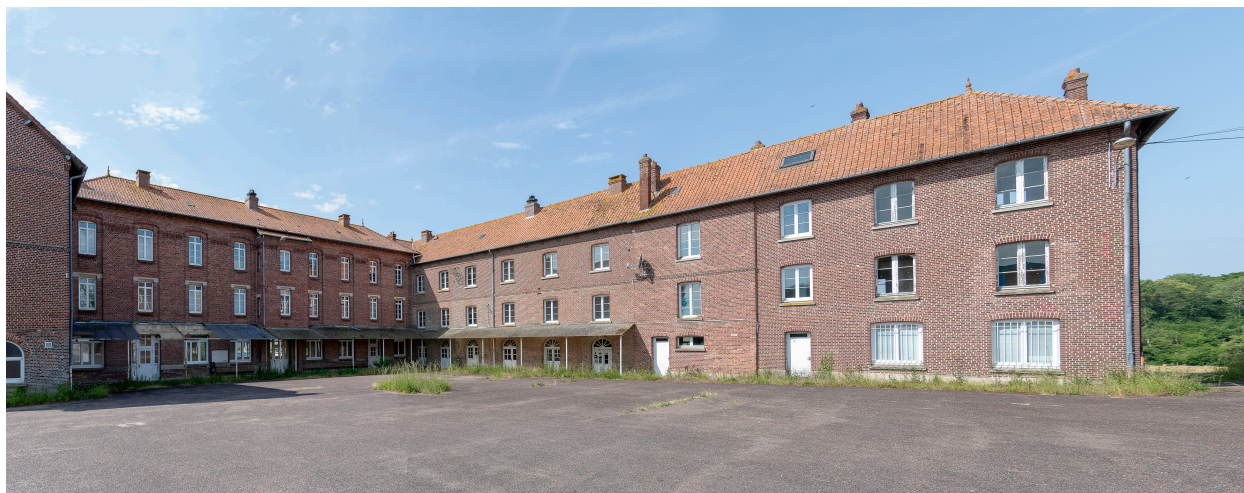
Vue générale des dortoirs depuis l'est.
