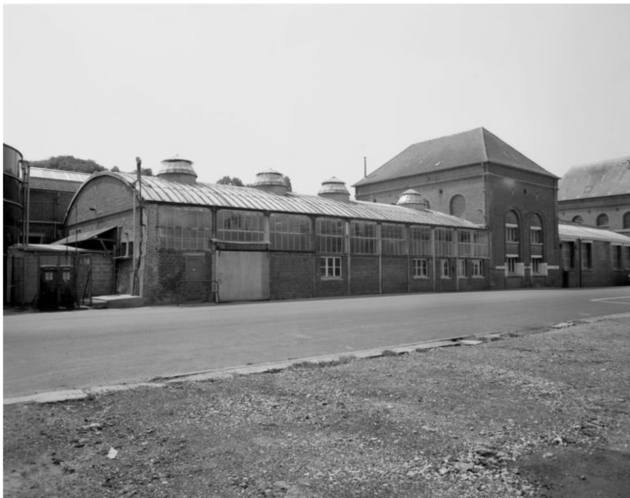
Vue partielle des ateliers de fabrication et de l'ancienne salle des machines, en 1989 : flanc nord est.
