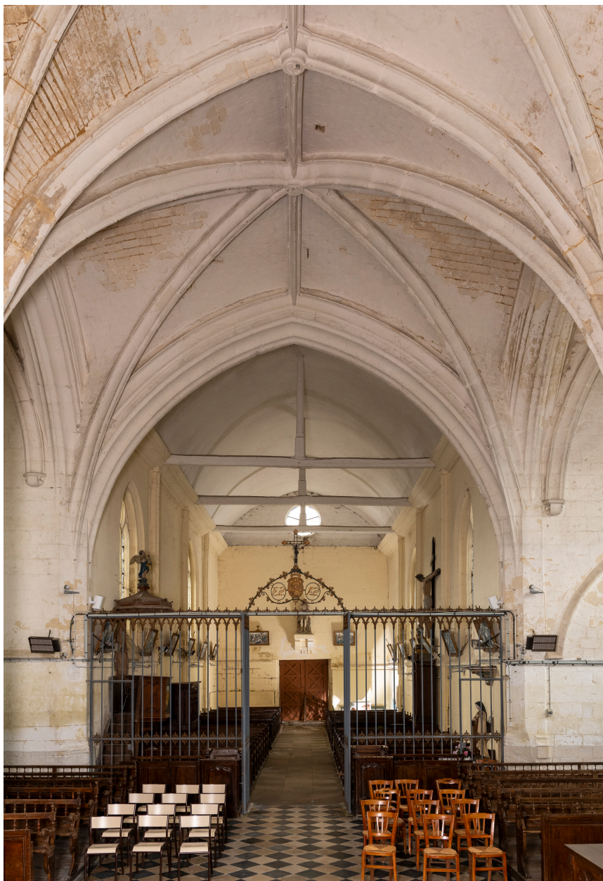
Vue intérieure vers la nef.
