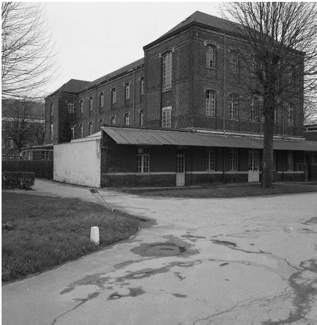
Bâtiment d'hospitalisation dit pavillon 5, élévation latérale gauche, vue de trois quarts gauche, avec l'élévation postérieure vue en enfilade.
