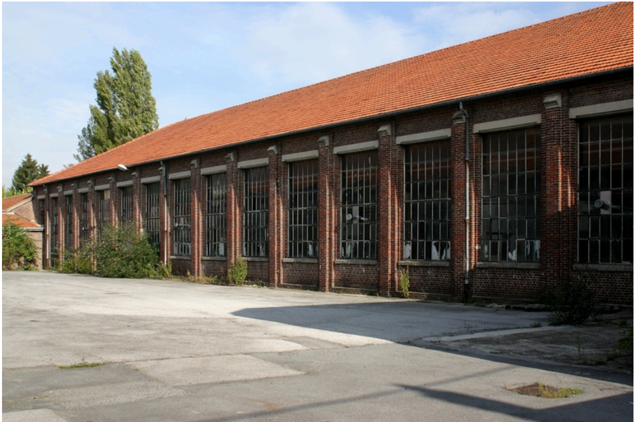
Façade occidentale de l'un des deux grands ateliers de guipure reconstruits à partir de 1919.
