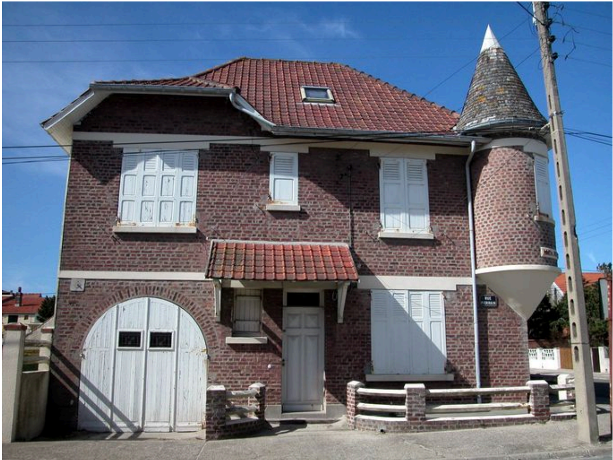
Elévation latérale, rue Pierrain.
