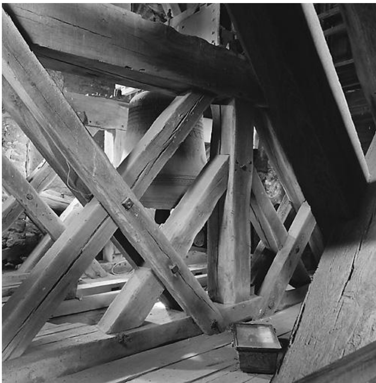
Chambre des cloches, beffroi : détail.
