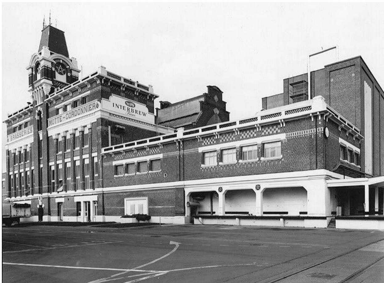
Brasserie et salle de fermentation, élévation antérieure.
