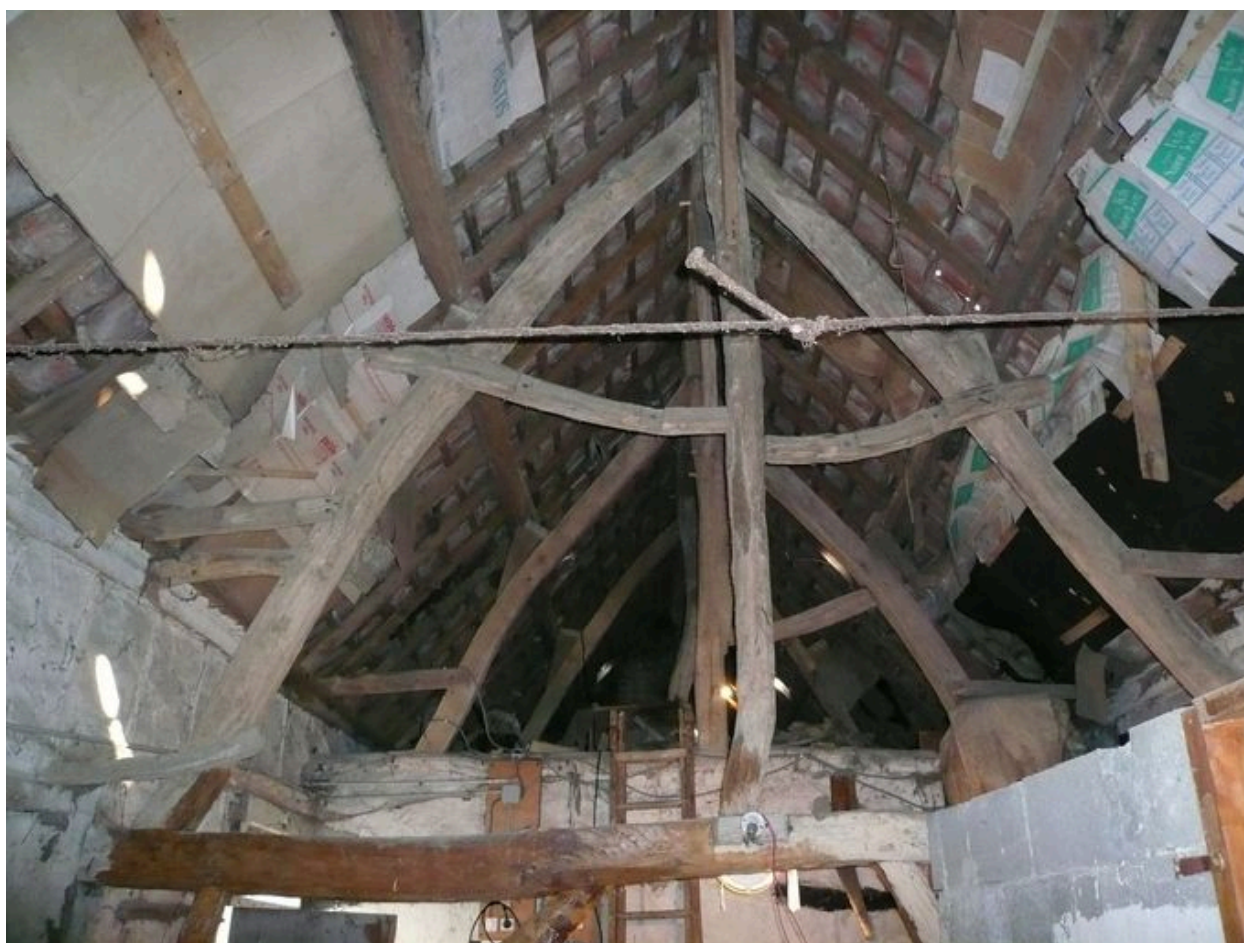
Vue de la charpente.
