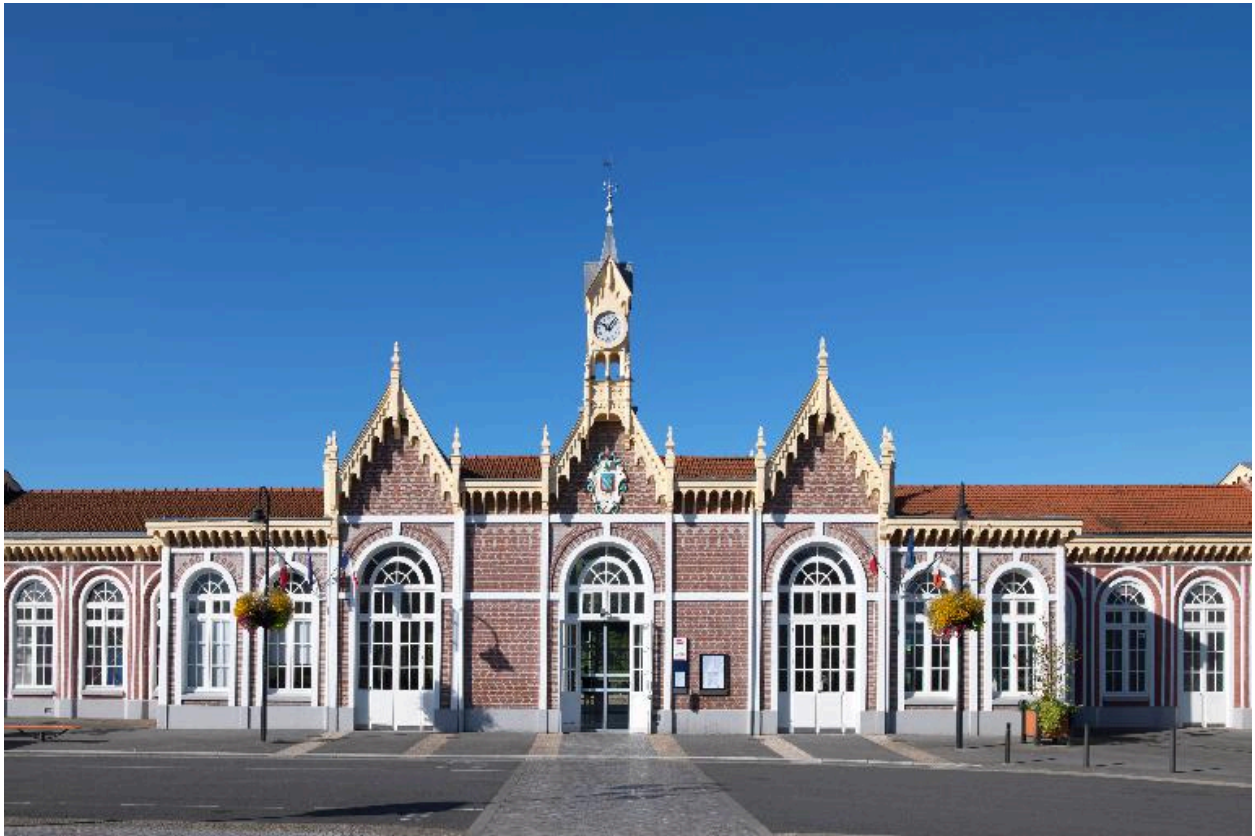
Avant-corps de la façade principale.
