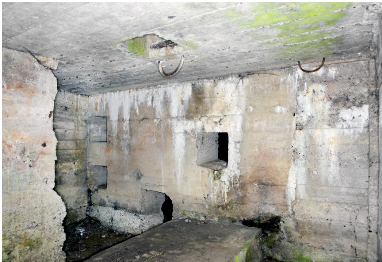
Salle sud : Massif bétonné du moteur diesel et quatre ouvertures débouchant salle nord (passage de tuyaux ?)
