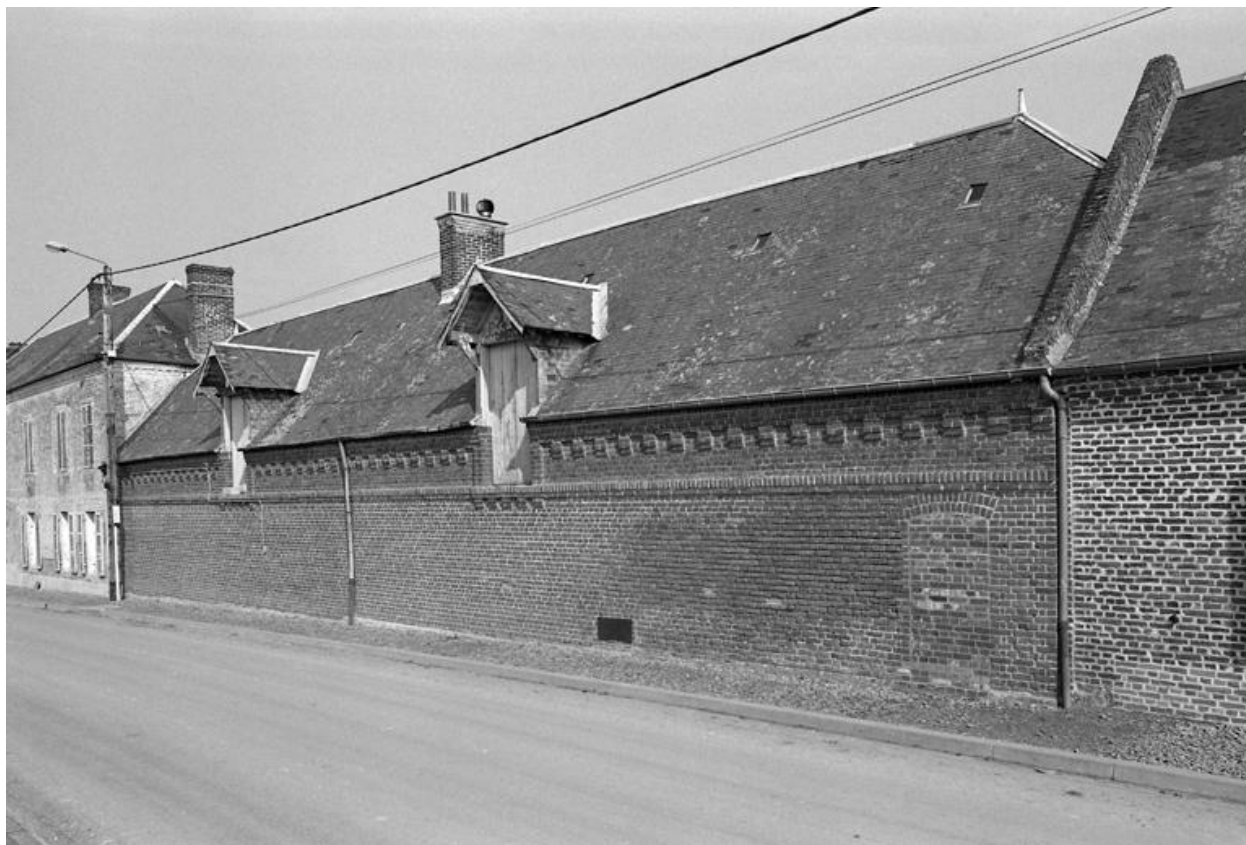
La laiterie. Façade sur la rue.
