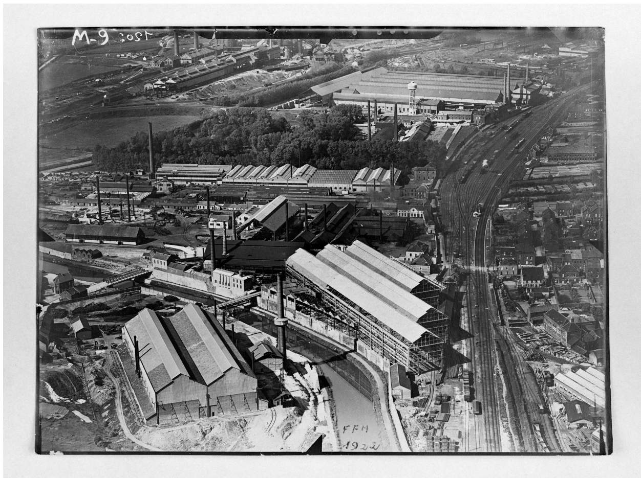
Les usines de Louvroil : au premier plan, reconstruction du gros train de l'usine F.F.M., puis Tôleries de Louvroil, Villeroy et Bach, Usinor. Photographie aérienne de Marcel Chrétien (?), 1922 (coll. part.).
