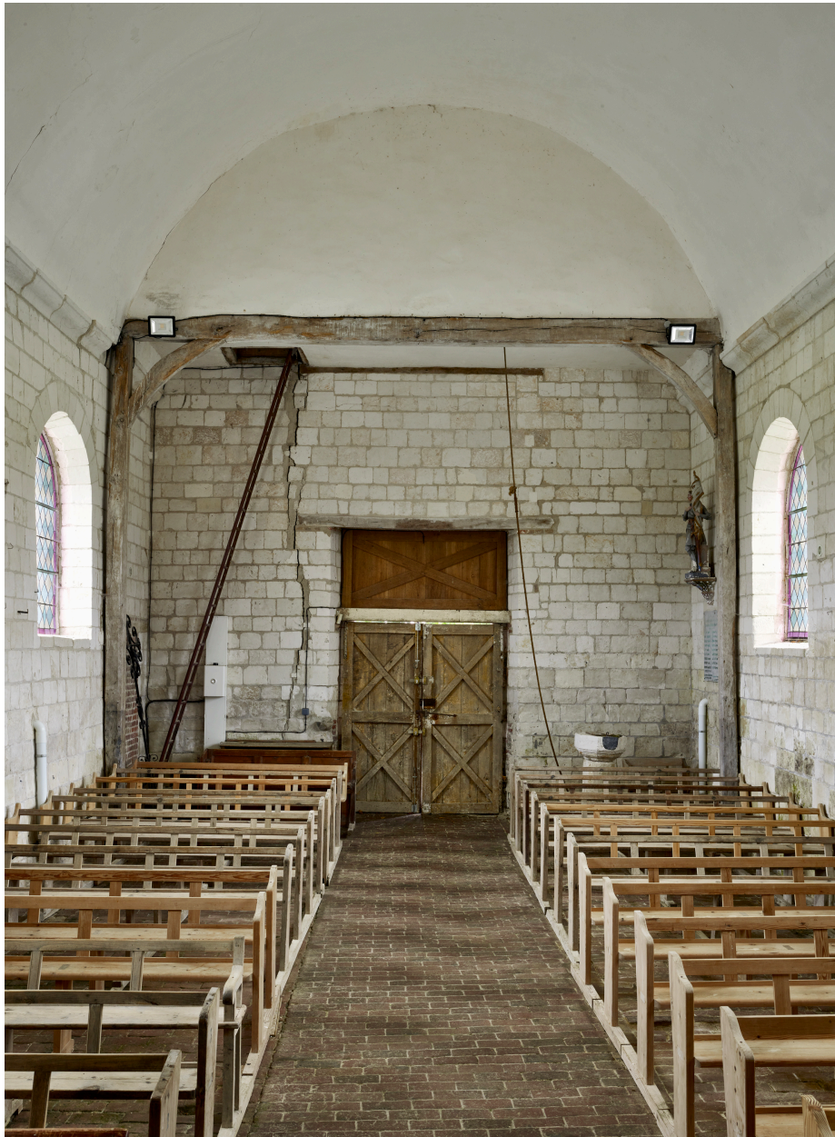
Intérieur, vue de la nef depuis le chœur.
