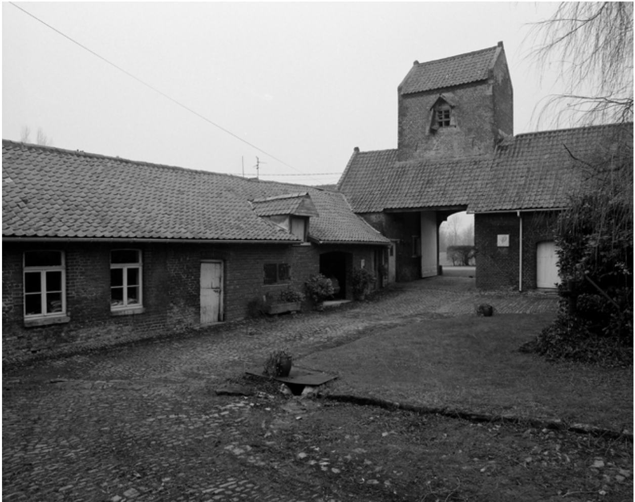
Vue générale de la cour : les communs et le pigeonnier-porche.
