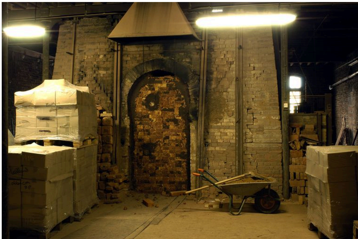
Façade du four ayant l'entrée obturée.
