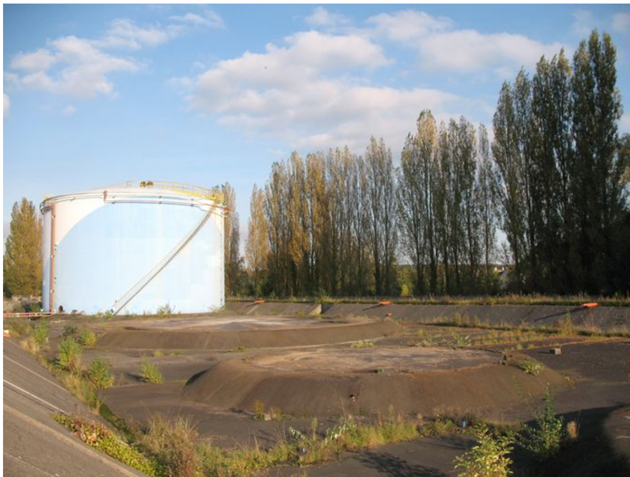
Cuve de méthanol construite en 1972 et emplacement des autres cuves.
