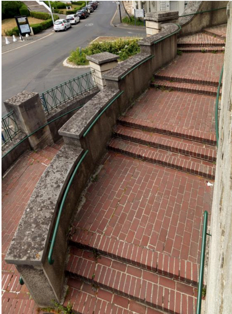
La rampe d'accès.
