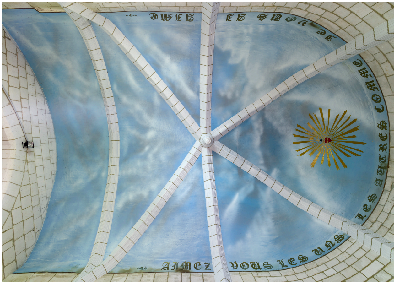
Intérieur, détail de la voûte du chœur.
