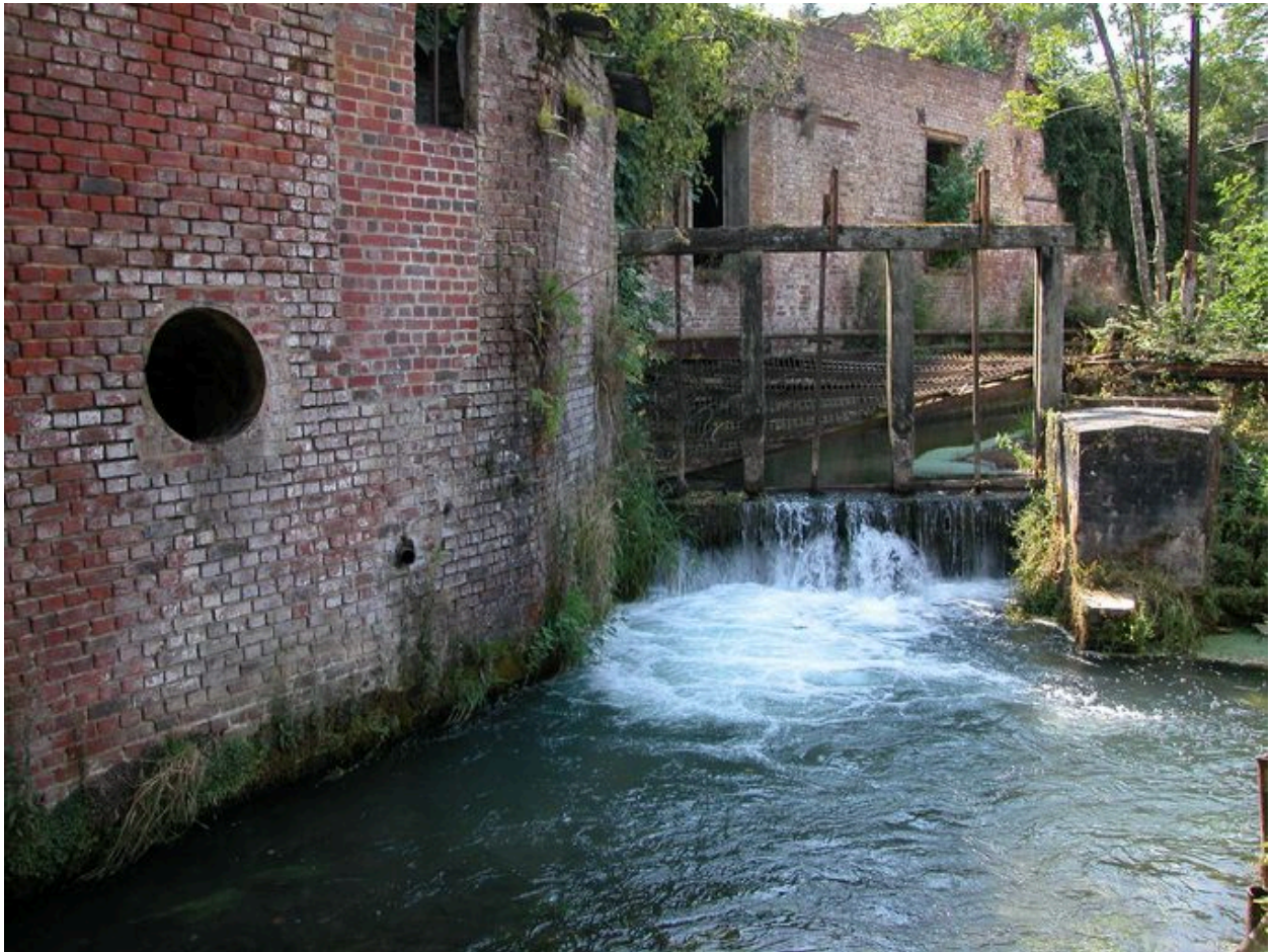
Détail du vannage de décharge.
