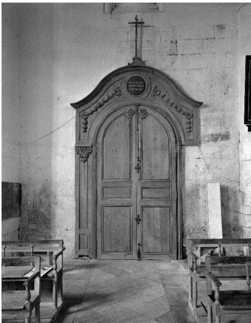
Vue de la porte occidentale et de son encadrement, lors de la restauration des lambris en 1988.
