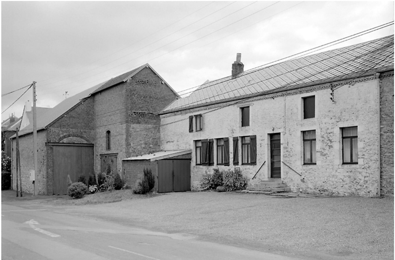
Vue de la ferme située 7 rue d'Avesnes
