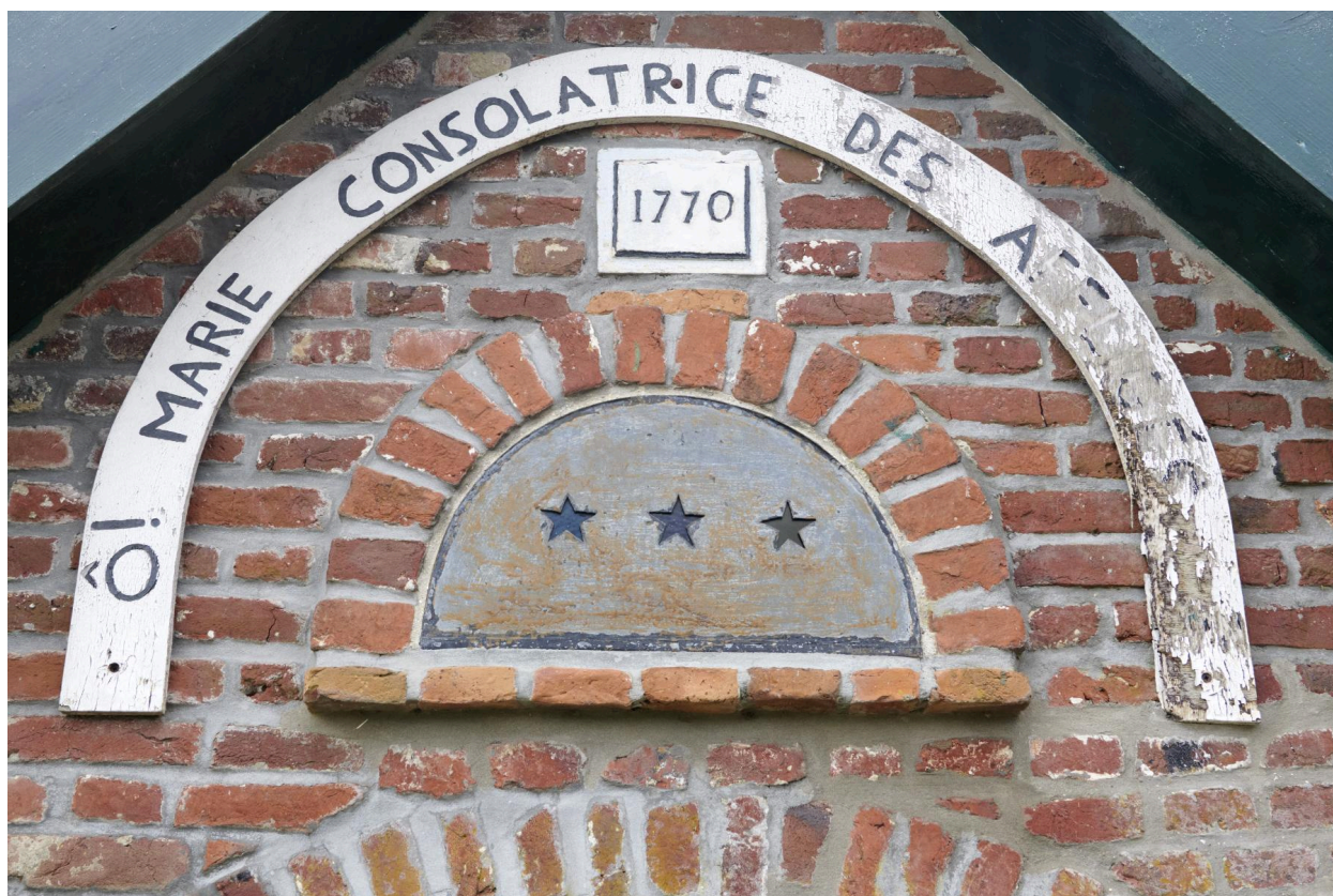
Détail du fronton avec date portée (1770).
