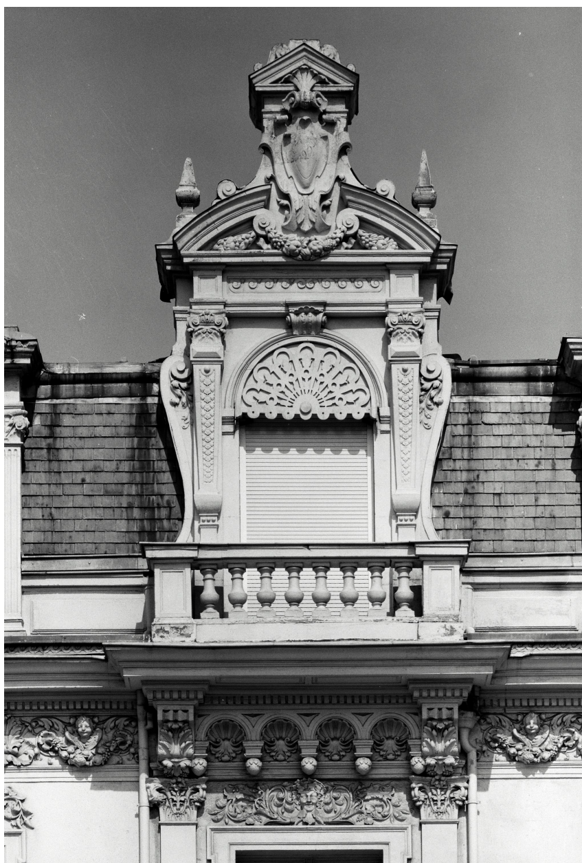
Façade sur voie, lucarne.
