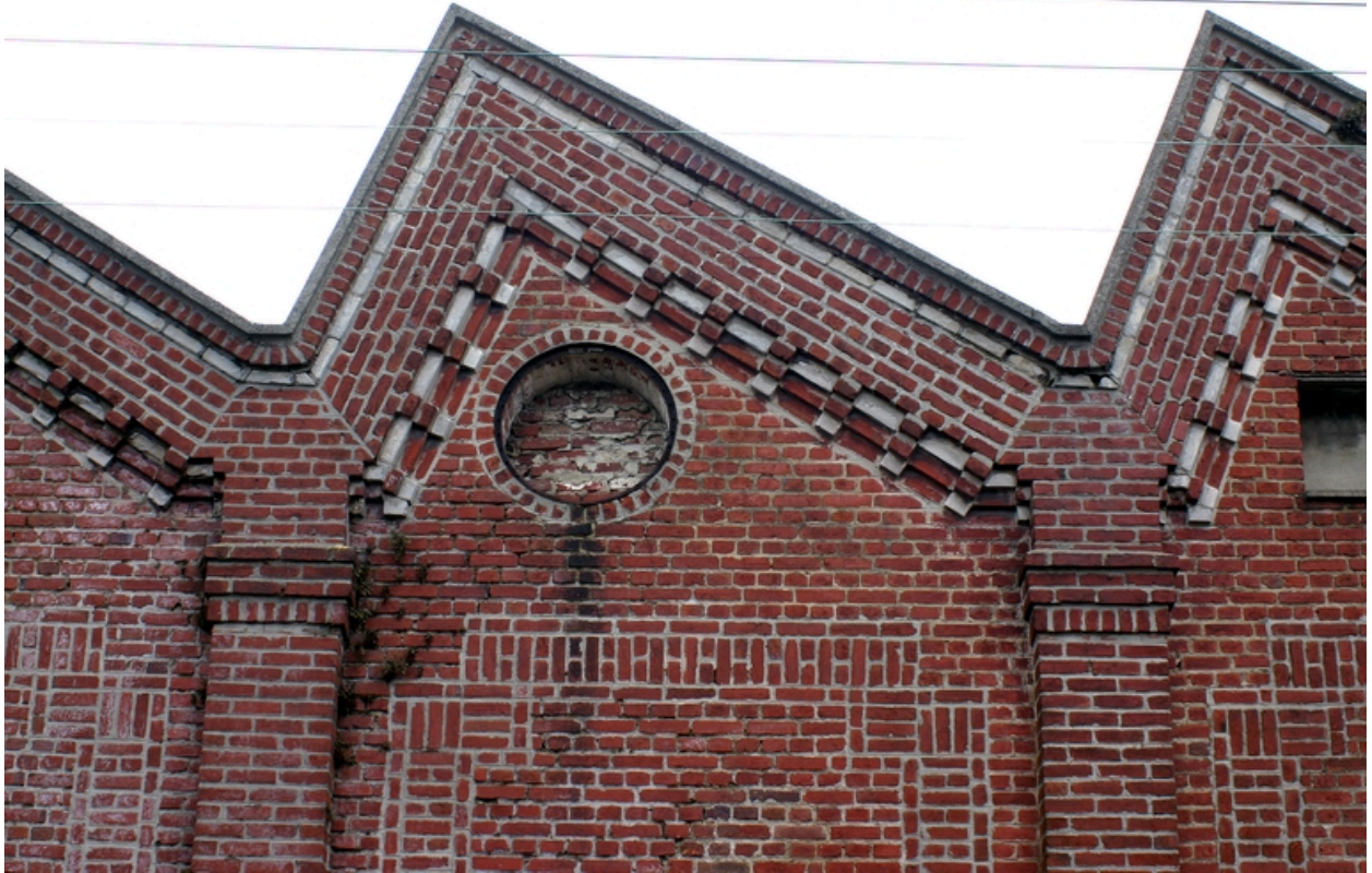
Détail de la façade de l'usine rue Turbigio : sheds.
