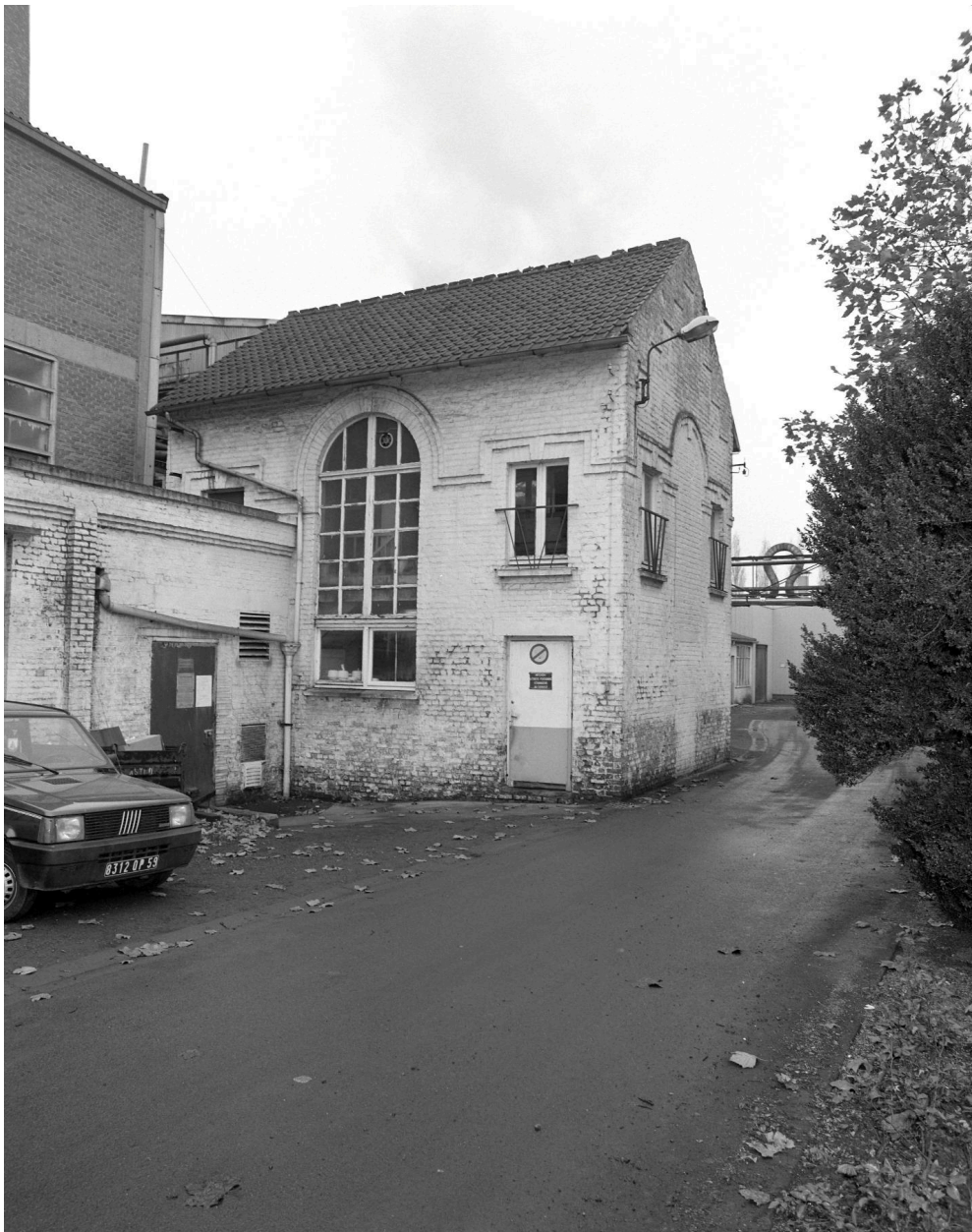
Ancienne salle des machines. Vue prise vers le sud.
