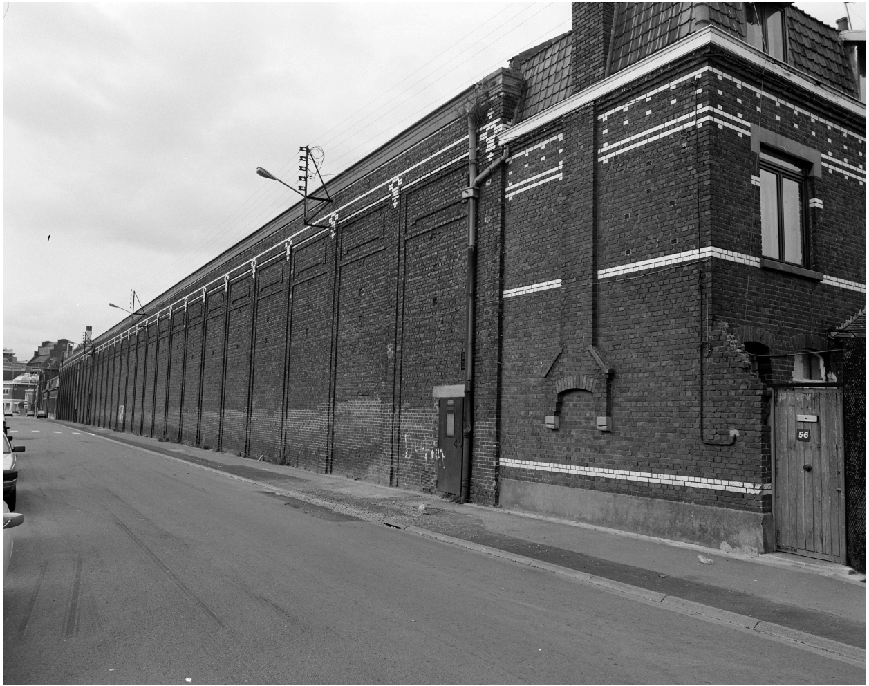
Élévation antérieure rue Roger Salengro. Vue prise vers le nord-est. À droite, la conciergerie sud-est suivie des magasins aux balles (de coton).
