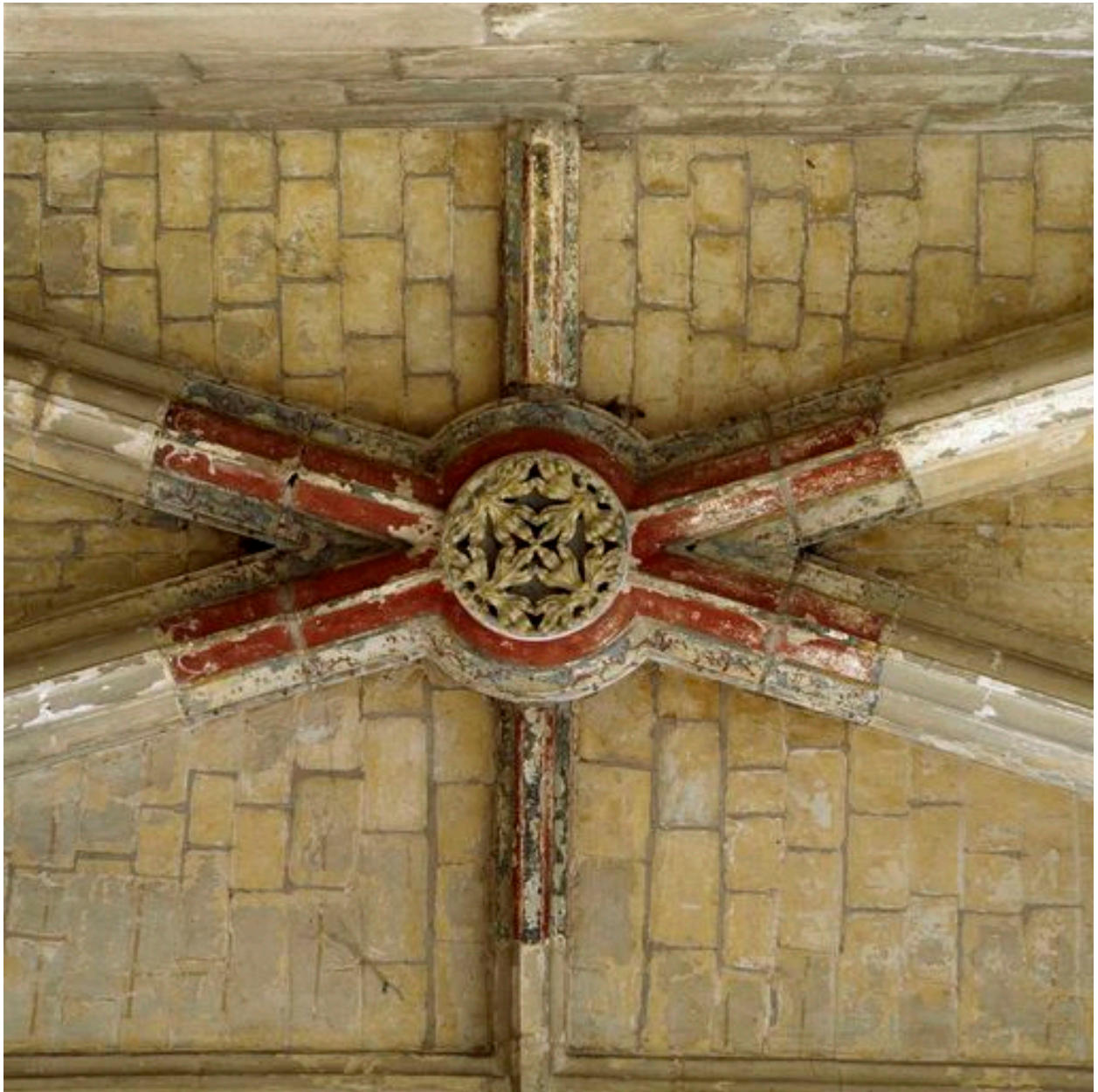
Voûte de la première travée du collatéral nord de la nef.
