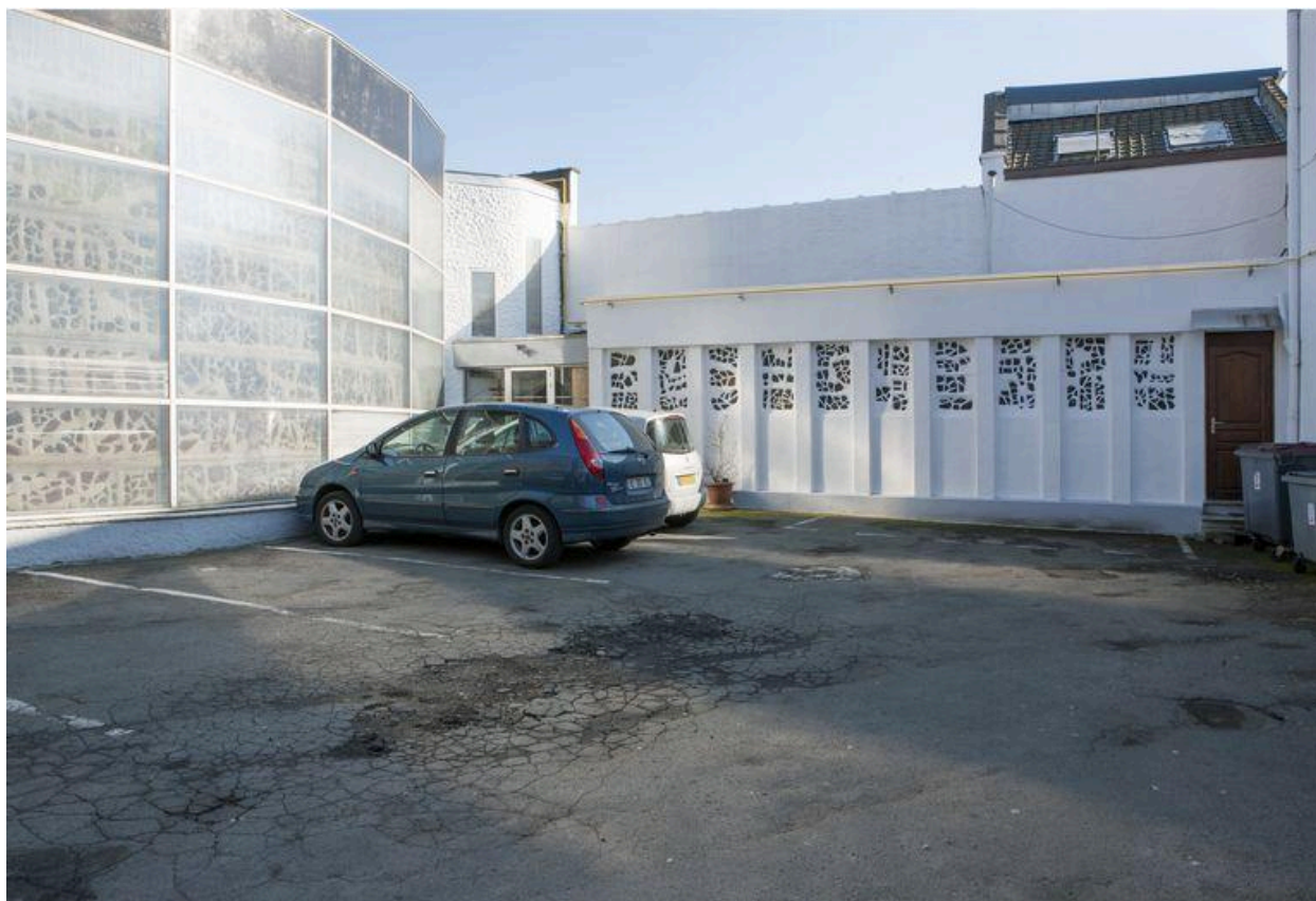
Vue de la salle paroissiale.
