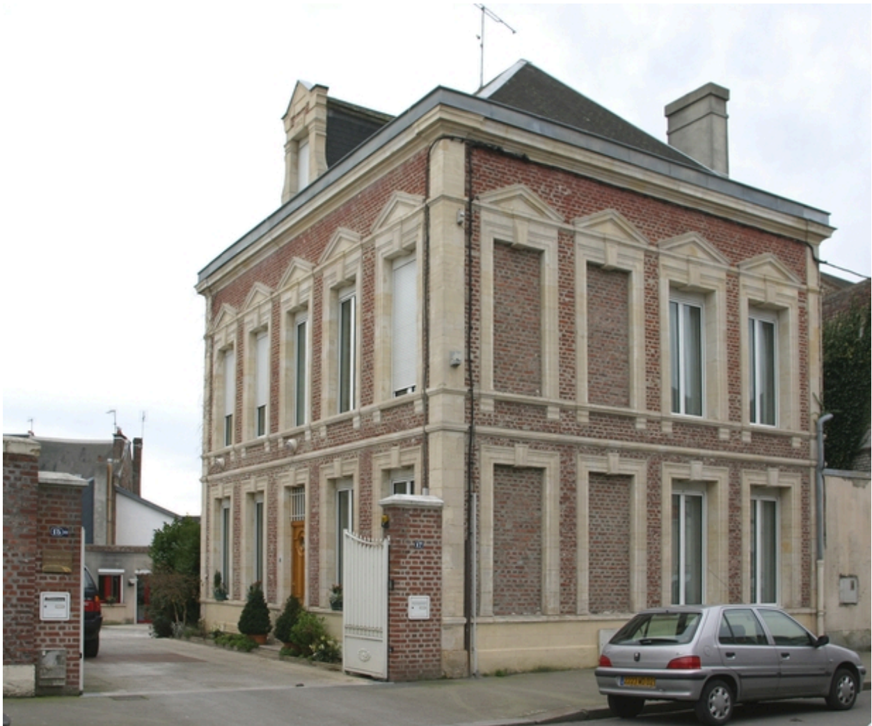
Le logement patronal.
