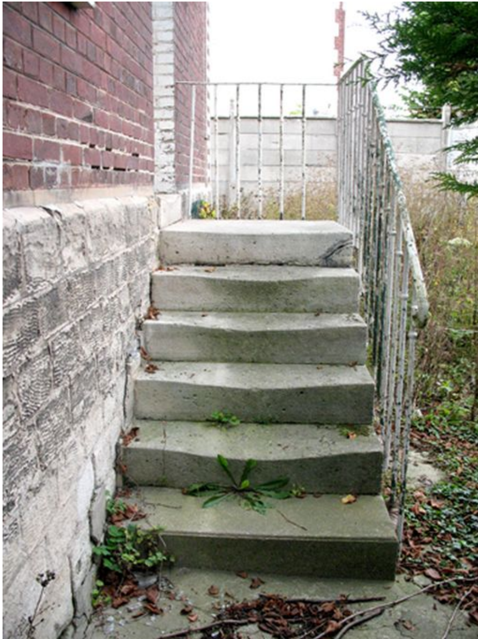
Escalier d'accès au logement d'un contremaître.
