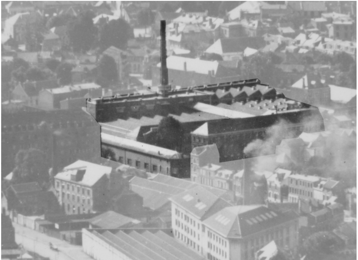
L'usine photographiée vers 1925 (BM Saint-Quentin).
