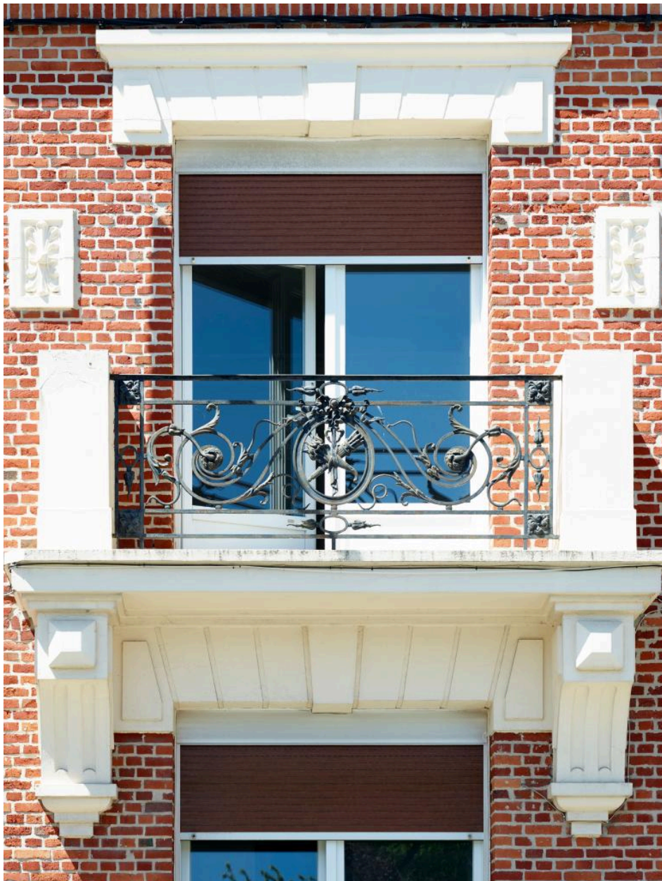
Détail d'un décor de garde-corps, maison n°10 rue de la Liberté.
