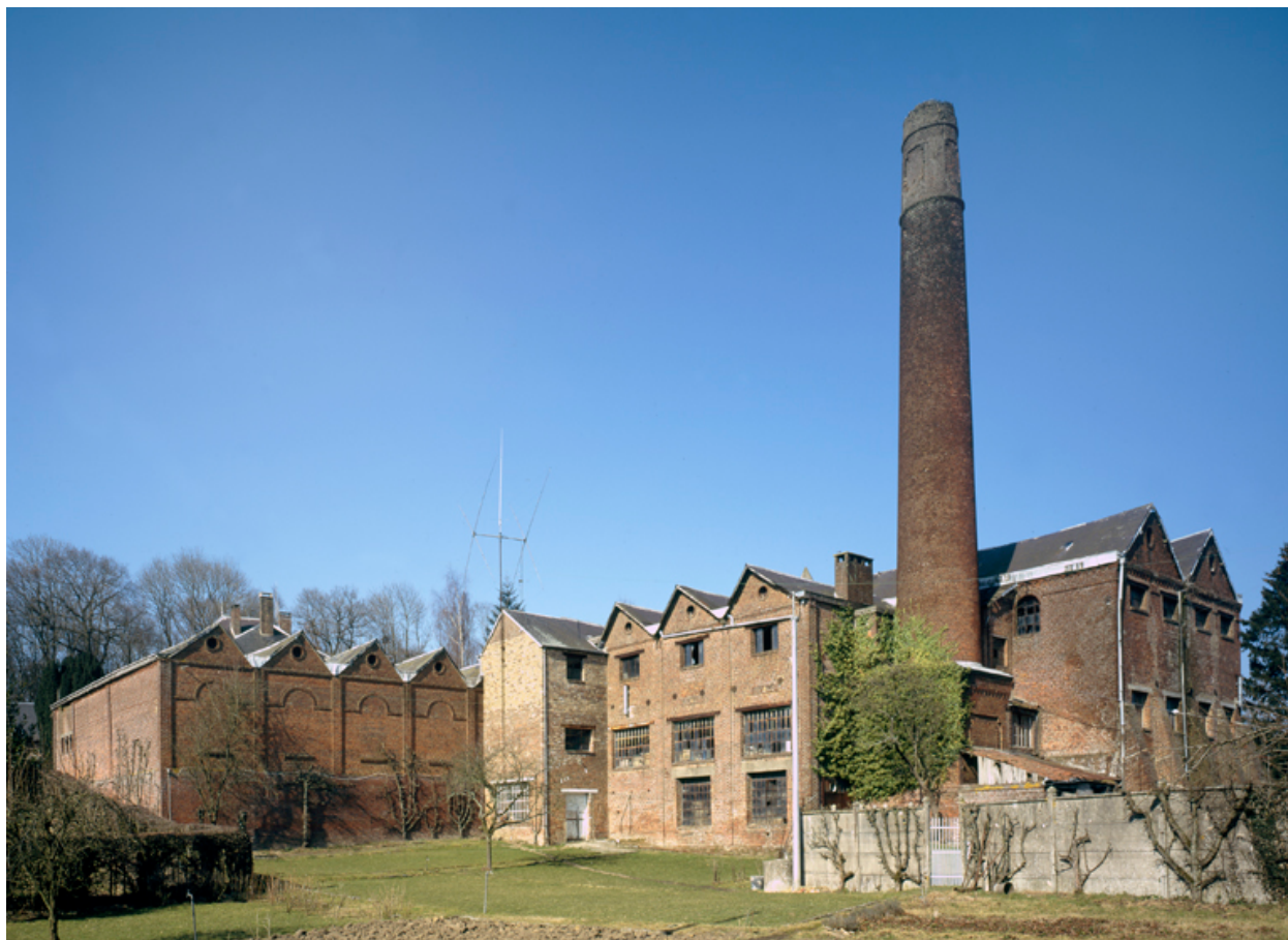
Vue générale de l'usine, depuis le sud.
