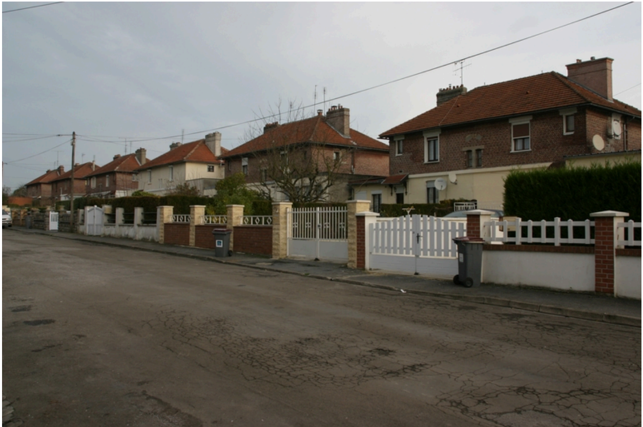
Façades, rue Jean-Moulin.
