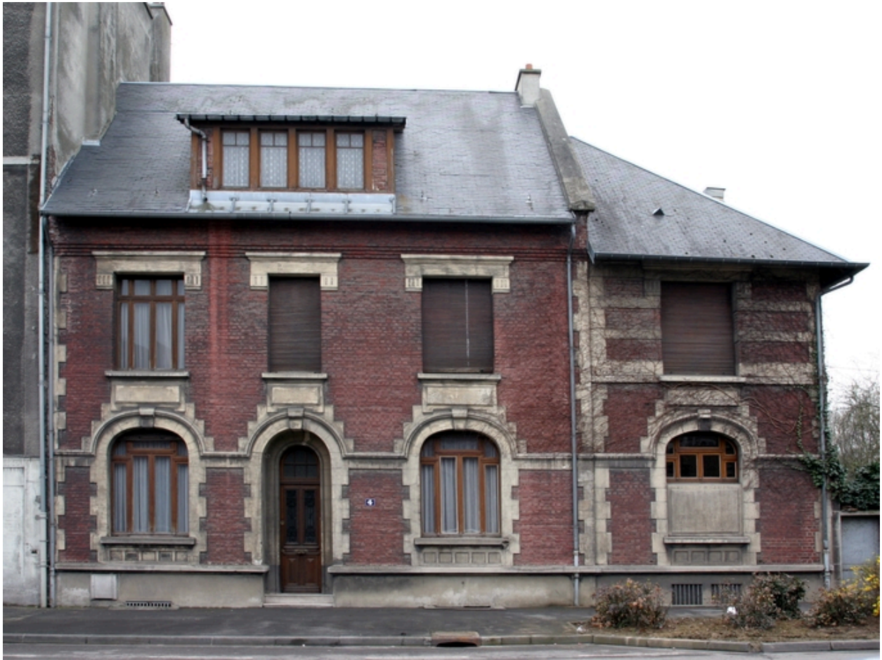
Façade antérieure du logement patronal de 1923.
