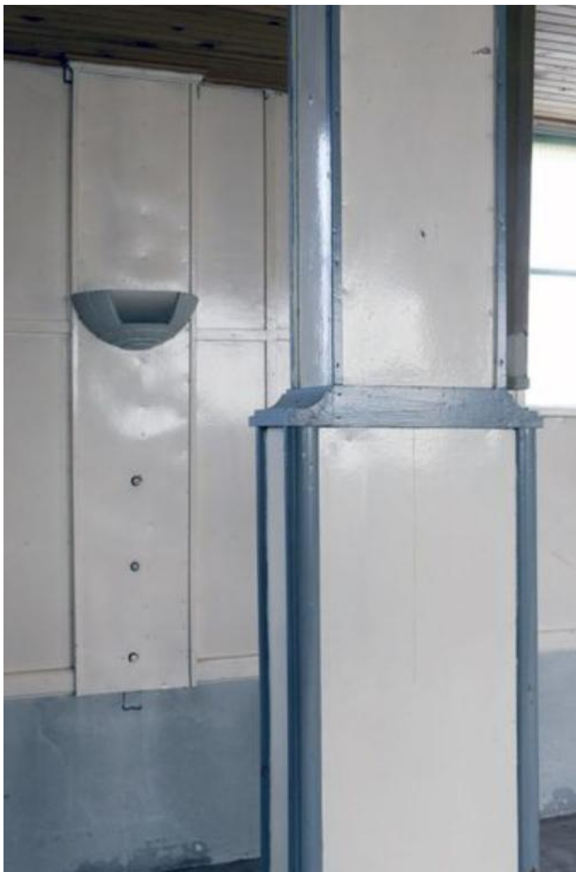
Détail d'un pilier de la nef.
