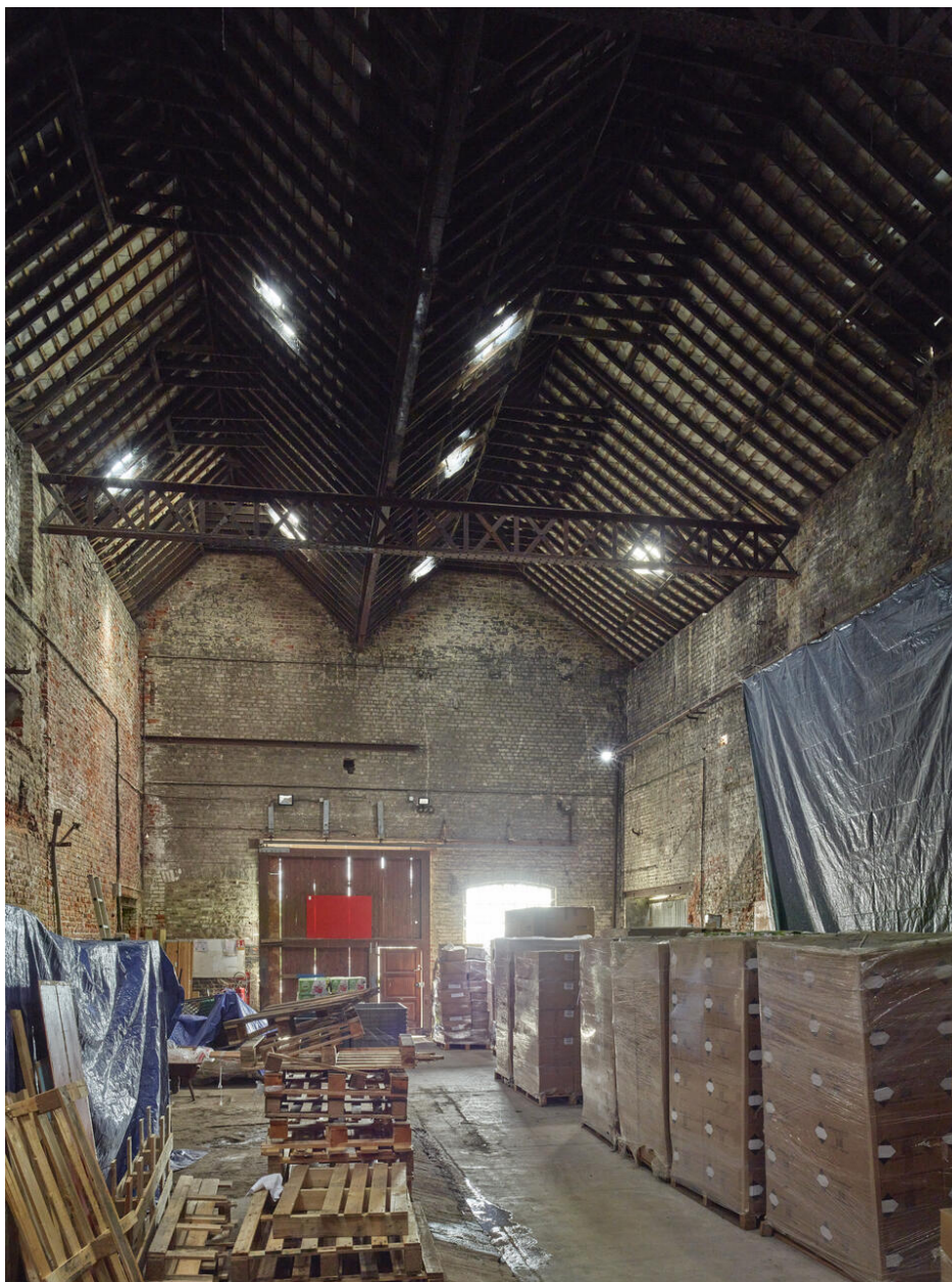
Intérieur de l'atelier attenant à la salle des générateurs.
