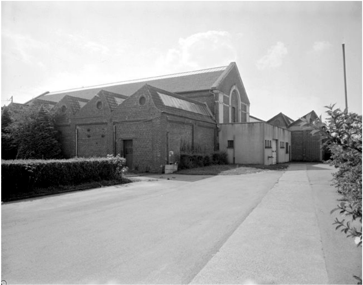
Corps du bâtiment C, flanc nord.
