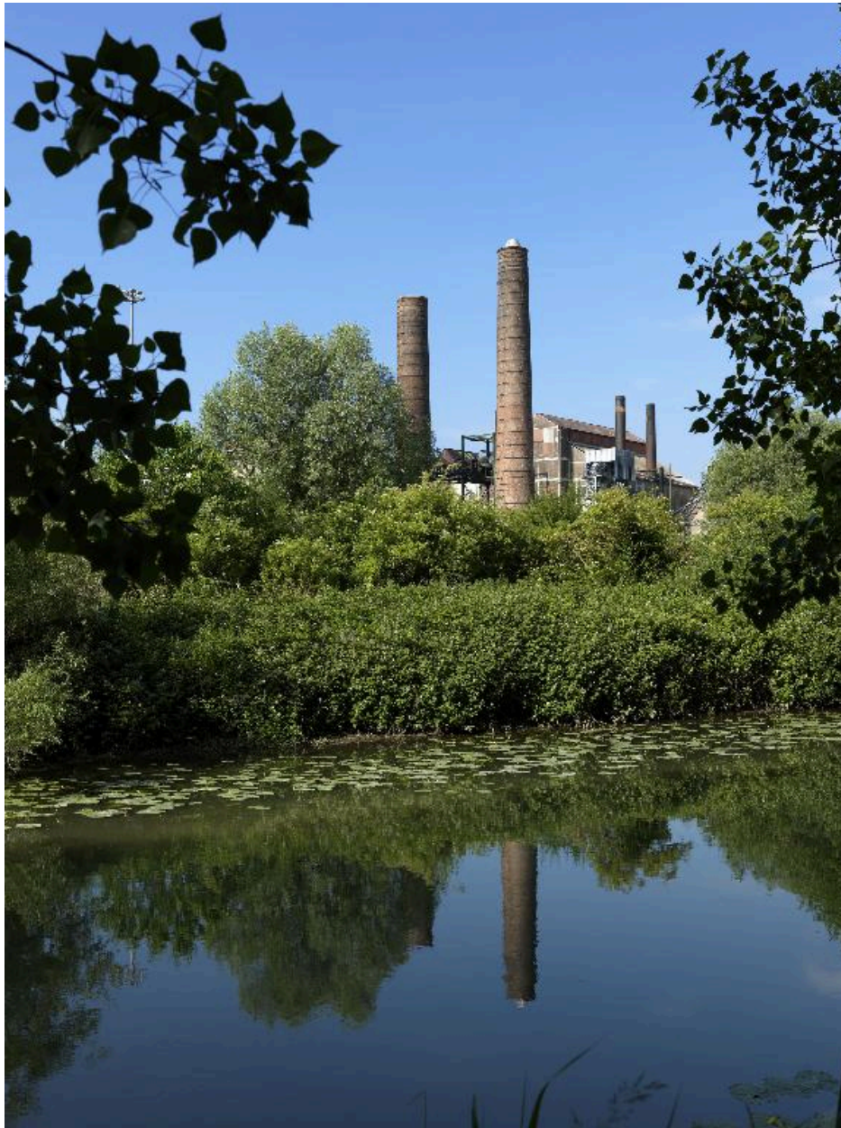
Les cheminées de la sucrierie depuis le chemin de halage.
