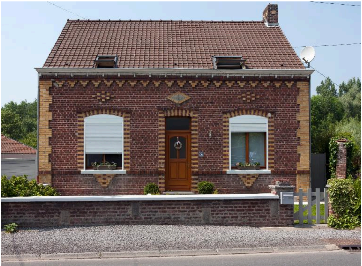
Vue générale de deux maisons de bateliers.
