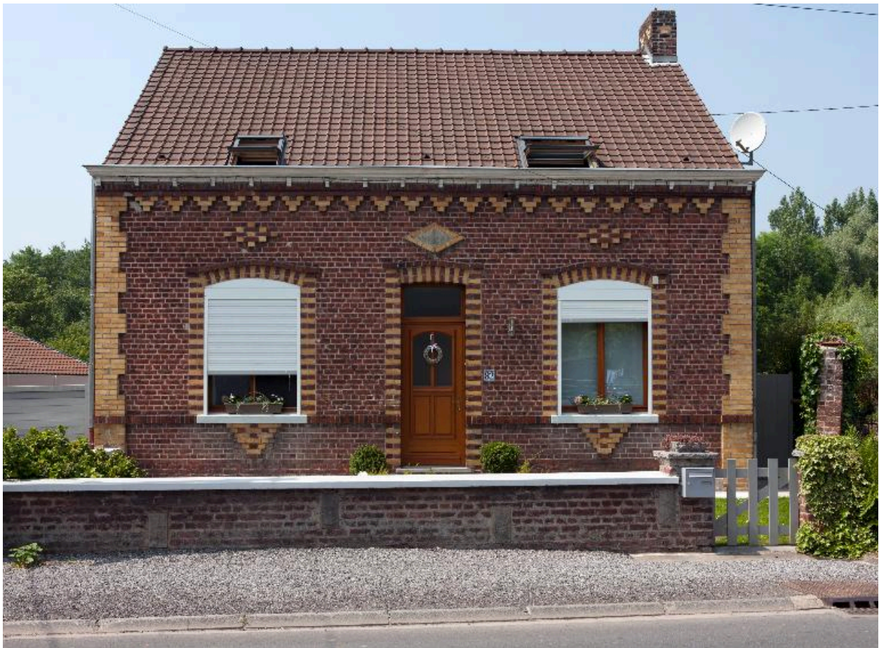
Vue générale de deux maisons de bateliers.
