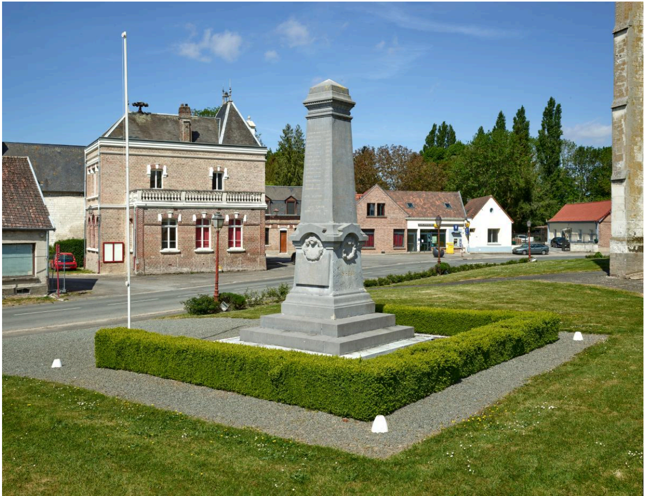
Vue générale de trois quarts depuis l'est.
