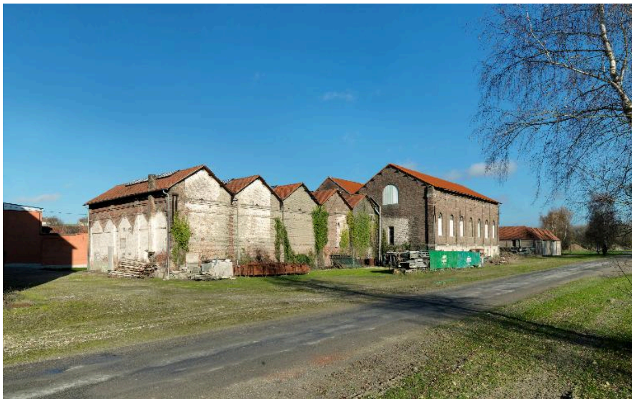
Bâtiment des batteries et des essais de câble.
