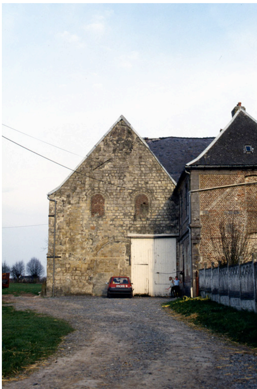
Vue de la façade de l'église abbatiale.
