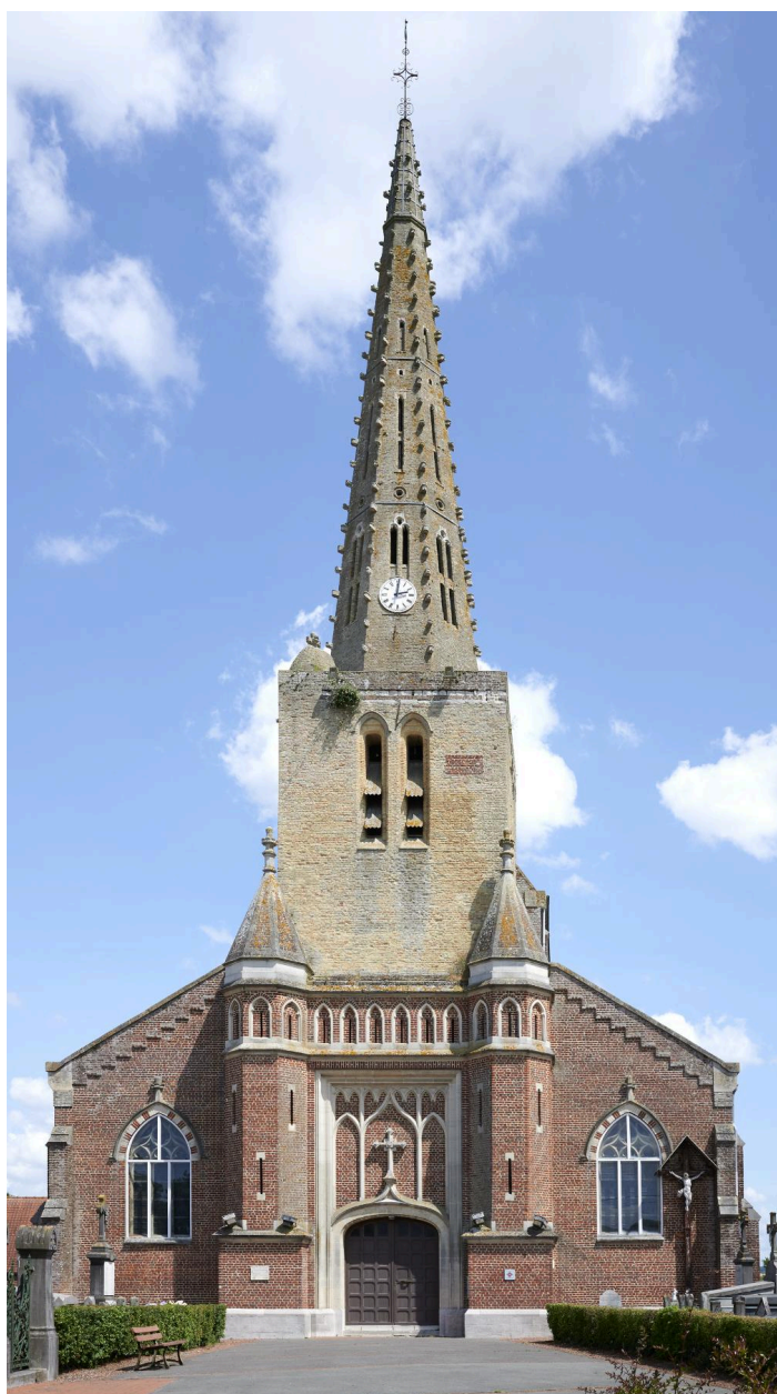
Façade principale de l'église.
