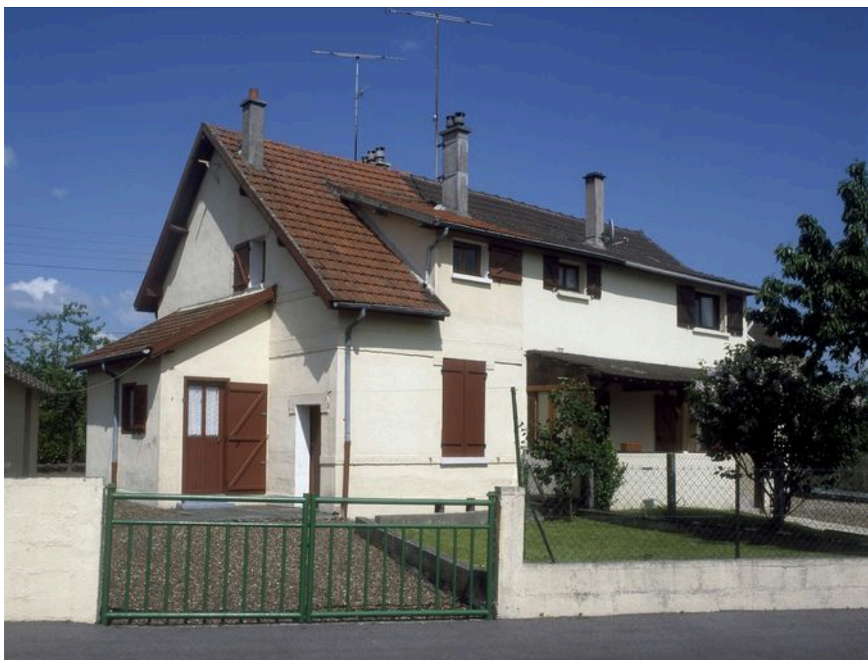
Maisons de cadre en logements jumelés.
