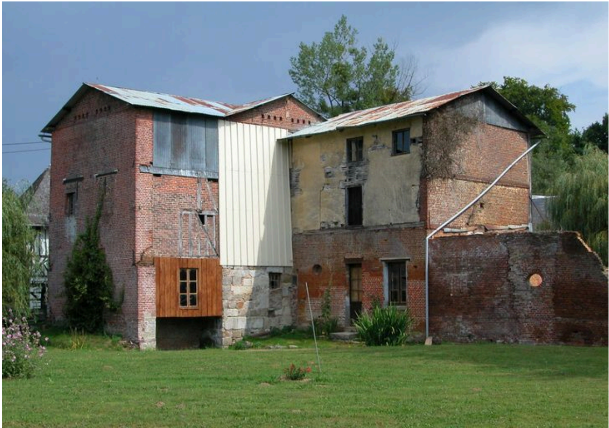
Vue d'ensemble sud du moulin.
