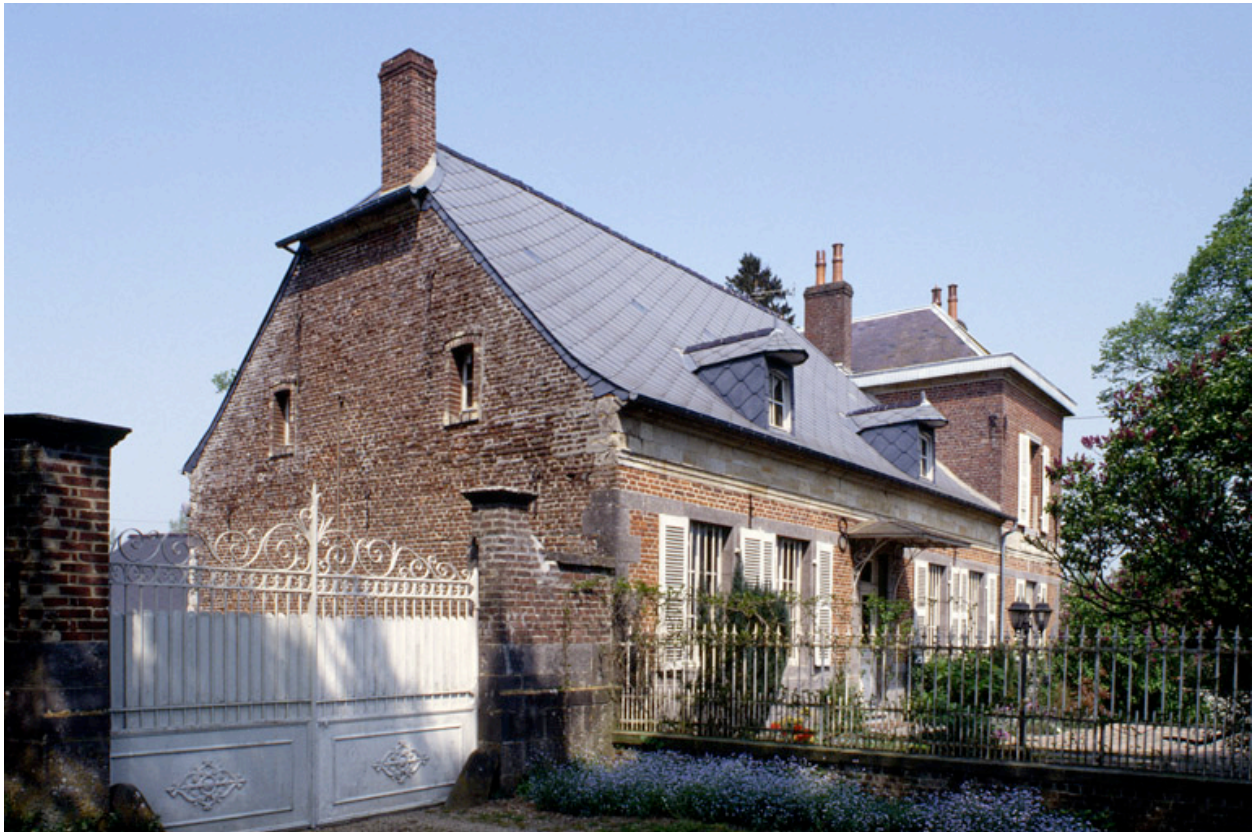
Vue d'ensemble du logis, depuis le sud.
