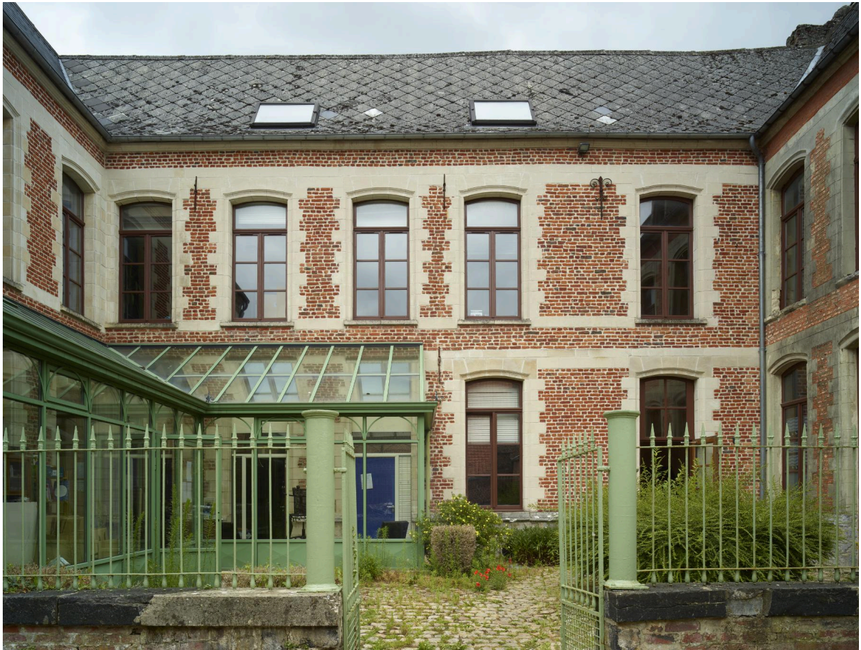
Façade sur cour de l'aile en retour d'équerre.
